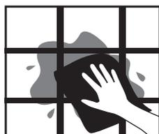
7. Entre 15 e 30 minutos, com o auxílio de esponja umedecida em água, limpar delicadamente a superfície com movimentos circulares. Repetir a operação até que as juntas fiquem lisas e no mesmo nível das bordas da cerâmica (trocar a água durante essa operação, mantendo a esponja sempre limpa). Remover o máximo possível do excesso do rejuntamento para evitar aderência do produto nas peças.
