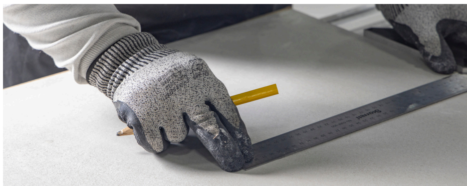
Imagem 84: Desenhe na peça o corte a ser realizado.
