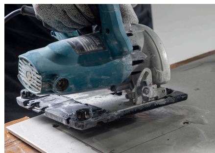
Imagen 82: Finalice la apertura de los cuatro círculos con la sierra de porcelanato.
