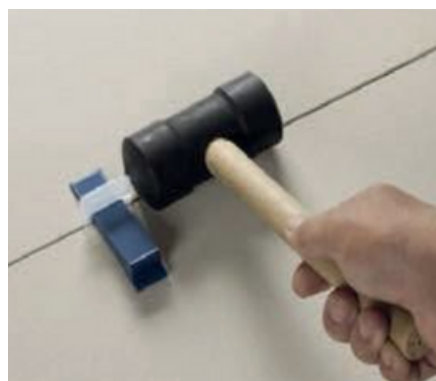
Imagen 44: Retirada del clip y cuña.
