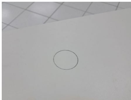
Imagem 89: Marcação do corte circular.
