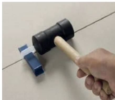
Imagem 44: Remoção do clip e cunha.
