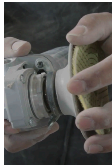
Imagem 102: Acoplagem do disco cerâmico na esmerilhadeira.
