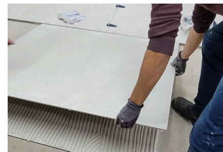
Imagen 33: Ejecución del arrastre en la pieza.
