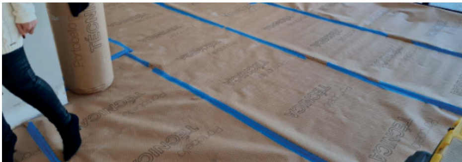
Imagem 46: Protetor de piso aplicado
