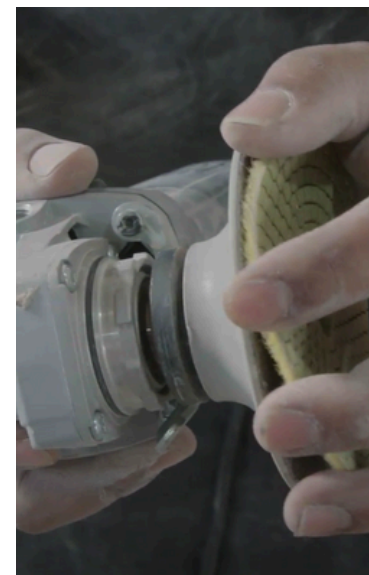
Imagen 102: Acoplamiento del disco cerámico en la amoladora.
