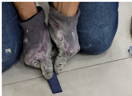
Imagen 35: Inserte la cuña en el clip de forma manual.
