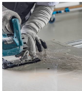
Imagen 87: Finalice la apertura del corte hasta el círculo utilizando la sierra de porcelanato.
