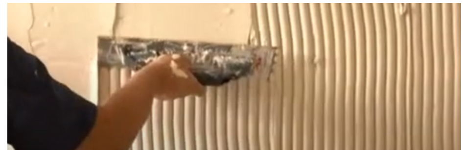
Imagen 28: Apertura de cordones en el revestimiento cerámico con el lado dentado de la llana.
