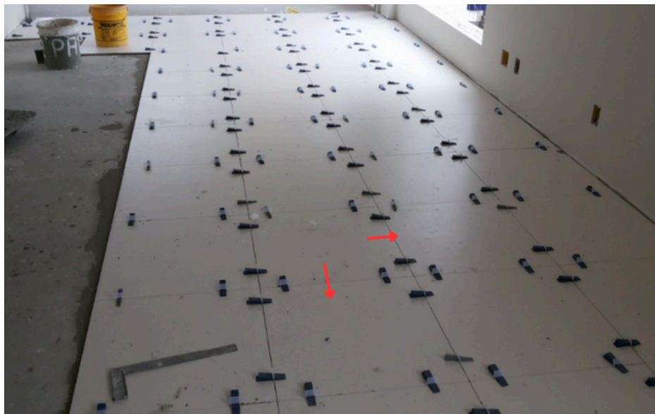
Imagen 42: Las cuñas de una misma hilera deben insertarse en la misma dirección.
