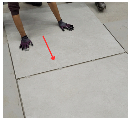
Imagen 30: Ejecución del arrastre en la pieza.
