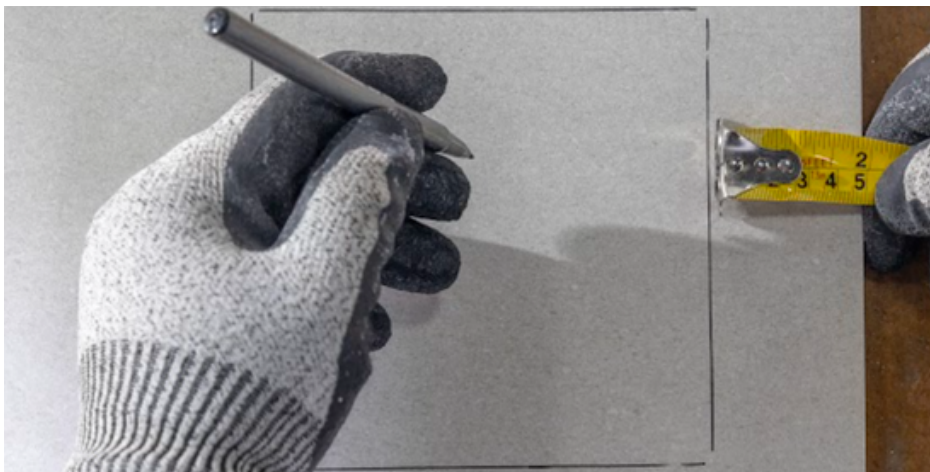
Imagem 79: Desenhe na peça o corte a ser realizado.
