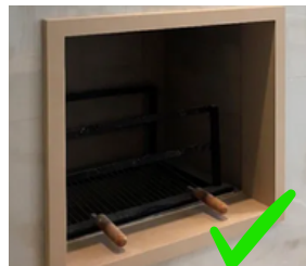
Imagen 11: Se recomienda el uso de revestimiento cerámico en la boca y en el marco del asador.
