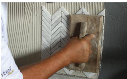
**Foto 21:** Uso da desempenadeira de borracha para nivelar as peças e esmagar os cordões.
