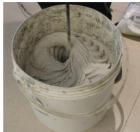
**Foto 15:** Mistura com haste helicoidal, formando uma pasta homogênea
