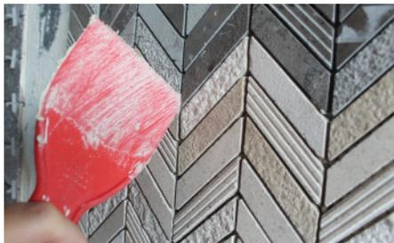
**Foto 24:** Remoção do excesso de argamassa colante com espátula plástica
