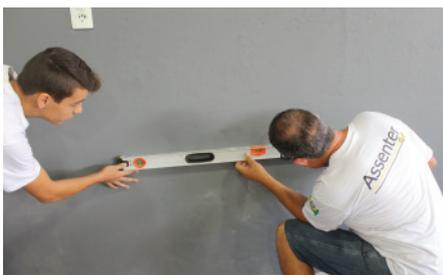
**Foto 11:** Verificação do nível da parede
