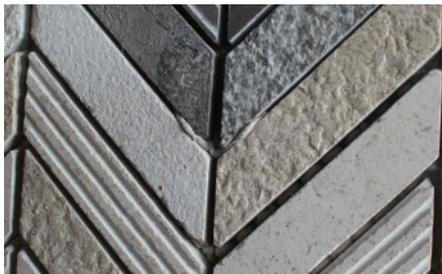
**Foto 23:** Excesso de argamassa colante nas juntas entre as pastilhas
