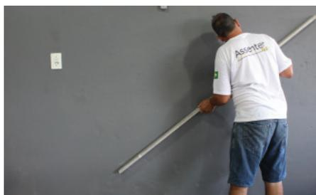
**Foto 08:** Verificação da planicidade da parede
