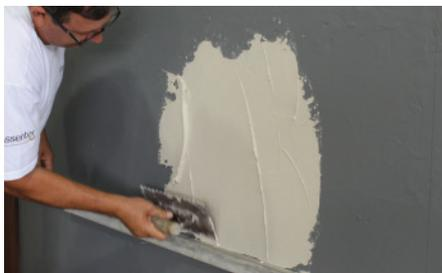
**Foto 18:** Aplicação argamassa colante na base de assentamento com lado liso da desempenadeira
