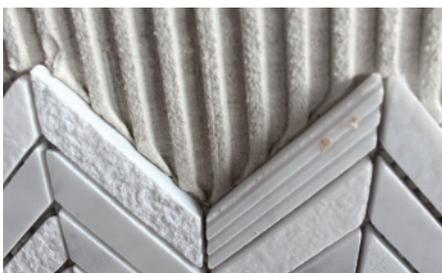
**Foto 22:** Na borda da peça percebe-se que os cordões foram esmagados
