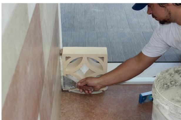
**Foto 14:** Remoção dos excessos de argamassa colante e preenchimento total da junta
