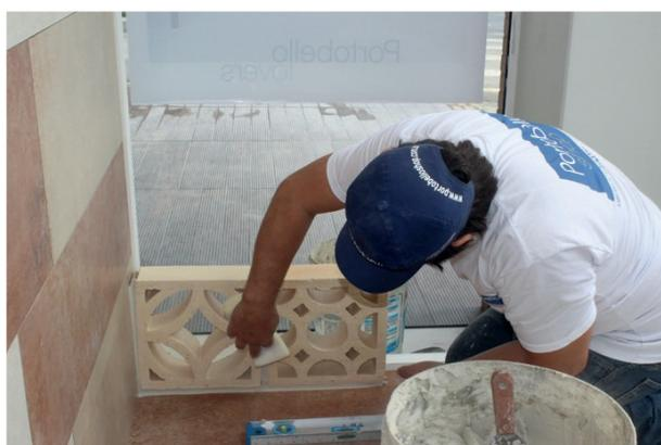
**Foto 15:** Remoção dos excessos de argamassa colante com esponja umidecida
