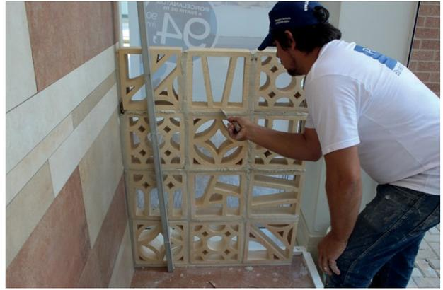
**Foto 21:** Assentamento com 1 metro de altura. Limpe os excessos de argamassa colante e continue o assentamento após 24 horas
