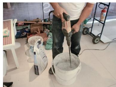
**Foto 11:** Mistura com haste helicoidal formando uma pasta homogênea
