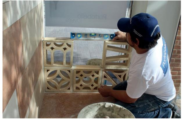
**Foto 17:** Verificação do nível após assentamento da última peça da fiada para esticar a linha de nylon
