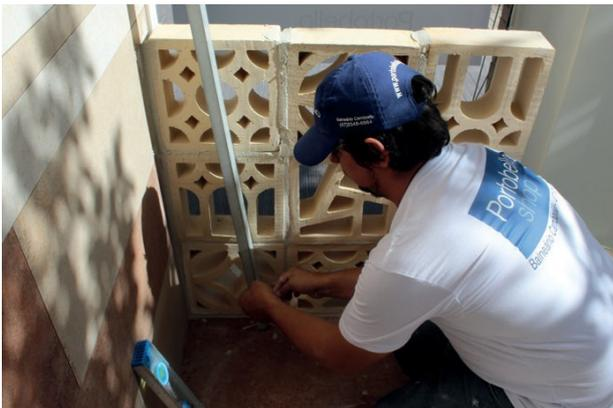
**Foto 18:** Fixação da linha de nylon na altura do primeiro bloco
