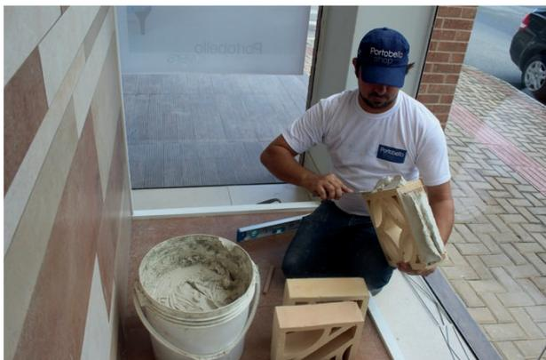
**Foto 12:** Aplicação argamassa colante nas laterais do cobogó
