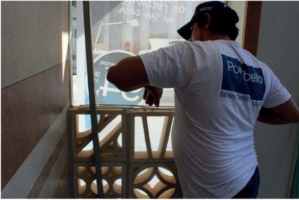
**Foto 20:** Fixação da treliça plana na segunda fiada do assentamento
