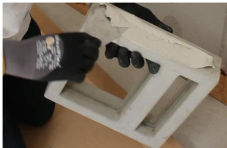
**Foto 13:** Aplicação da argamassa colante nas laterais do Cobogó
