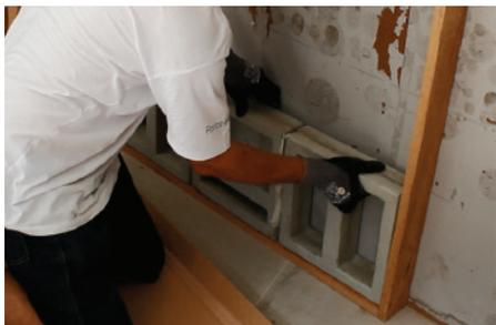
**Foto 15:** Remoção dos excessos de argamassa colante e preenchimento total da junta
