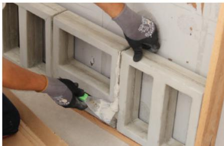
**Foto 16:** Remoção do excesso de argamassa colante da junta
