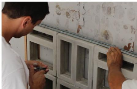
**Foto 17:** Fixação do ferro de 5mm na terceira fiada do assentamento
