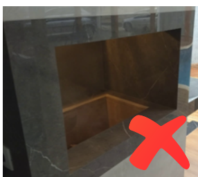
Imagem 10: Não é indicado assentar revestimento na parte interna da churrasqueira confeccionada em porcelanato, precisa ser tijolo refratário.
