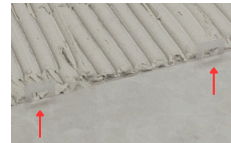
Imagem 32: Espaçador do tipo nivelador.
