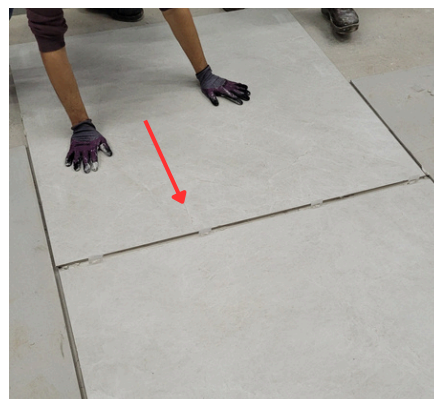
Imagem 30: Execução do arraste na peça.
