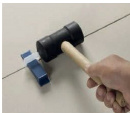
Imagem 44: Remoção do clip e cunha.
