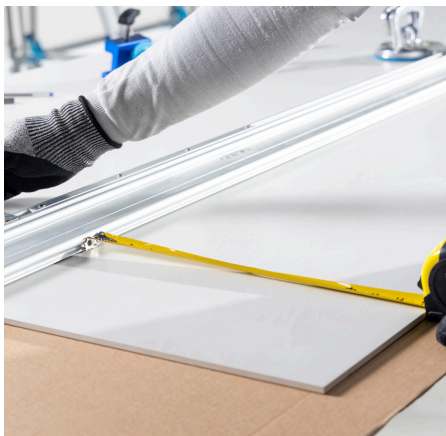
Imagem 70: Marcação do encaixe do trilho.
