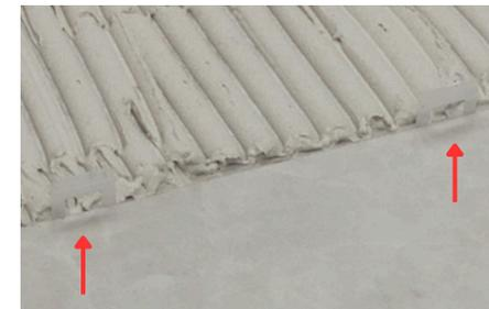
Imagen 32: Espaciador del tipo nivelador.
