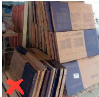
Imagen 04: Apilamiento inadecuado.
