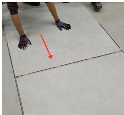
Imagen 30: Ejecución del arrastre en la pieza.
