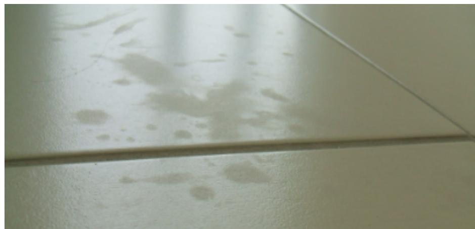
Imagen 103: Daño químico causado por el goteo de un producto no recomendado.
