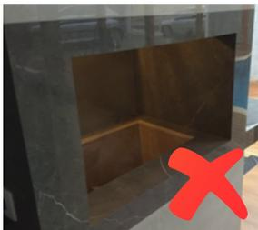
Imagen 10: No se recomienda asentar el revestimiento en la parte interna del asador de porcelanato; debe ser ladrillo refractario.
