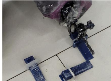
Imagen 36: Realice el ajuste con alicate de presión.
