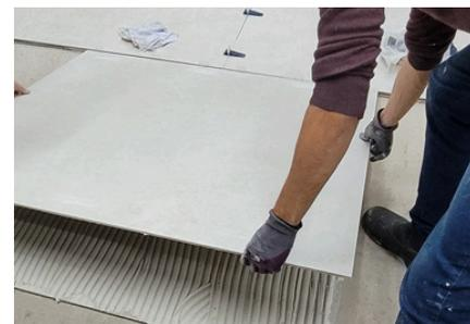
Imagen 33: Ejecución del arrastre en la pieza.
